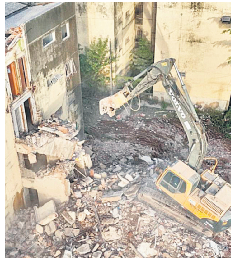
As unidades condenadas começaram a ser derrubadas
